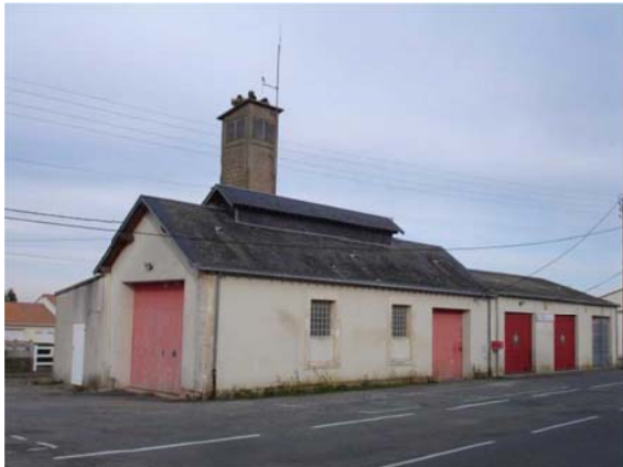
Ancien local des pompiers
